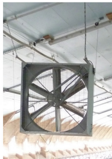
Stützventilator stationär
