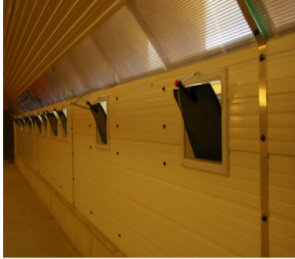
Unterdruck-Lüftung
