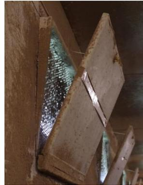
Abb. 83: Das Windnetz in der Zuluftklappe sollte gereinigt werden.
