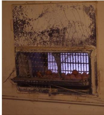
Abb. 82: Durch ein defektes Netz gelangen Hennen in das Zuluftelement und praktizieren hier die Eiablage.
