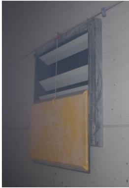
Abb. 81: Die fehlende Lamelle in der Zuluftöffnung sollte schnellstmöglich ersetzt werden.
